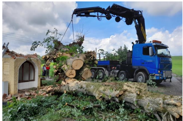
Kranwagen von Fa. Grömer beim Entfernen des Baumes
